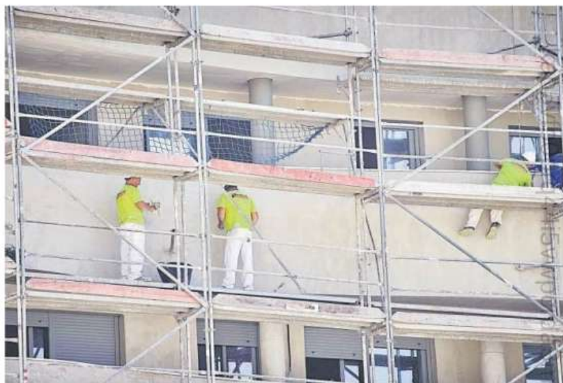
Trabajadores de la construcción en una obra.
