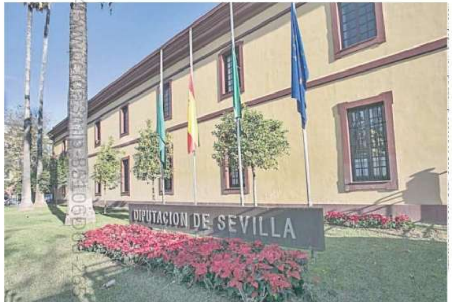
La sede de la Diputación Provincial de Sevilla, en la avenida Menéndez Pelayo.
