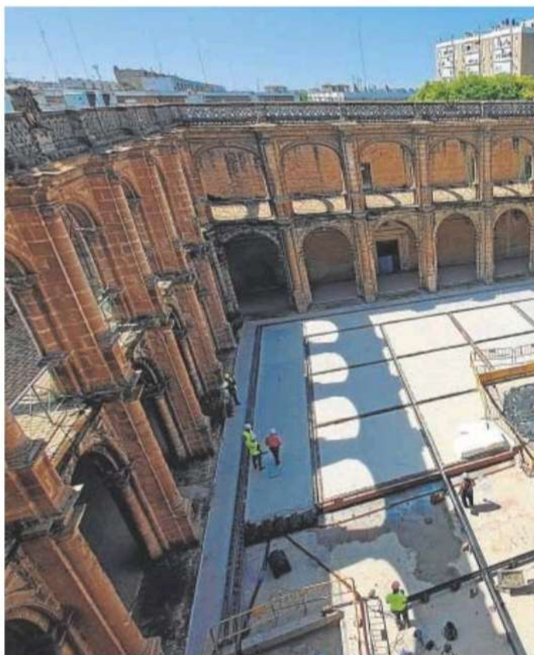
Estado de las obras en el claustro del antiguo monasterio de San Jerónimo // ABC
