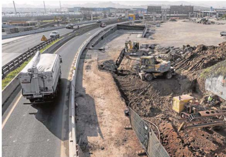
Acceso en obras a la autovía A-67 (Santander)
